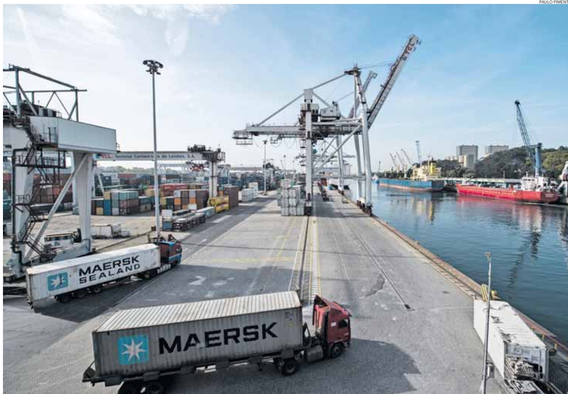
Obra passa pelo prolongamento do molhe sul e aprofundamento da bacia de rotação de navios para um novo terminal de contentores
